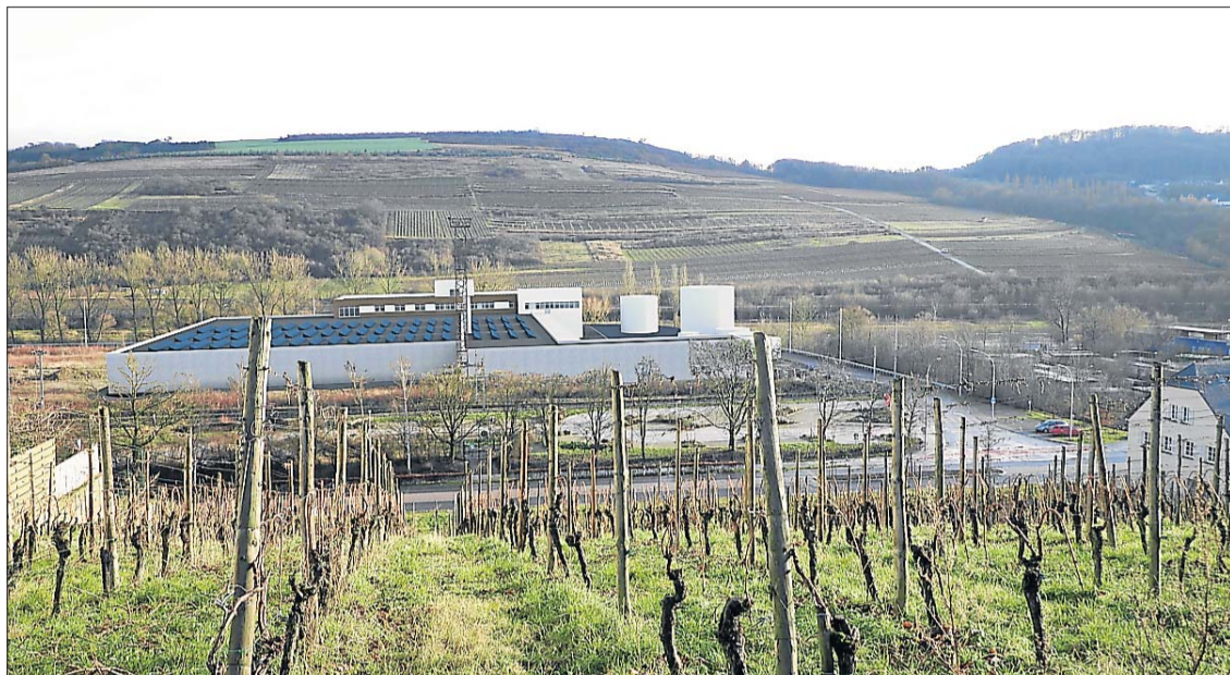
Die Kläranlage entsteht nahe dem Schmetterlingsgarten.
